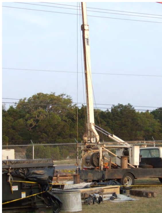
Photo 2.2 – Installation of CS-MW36-LGR.
