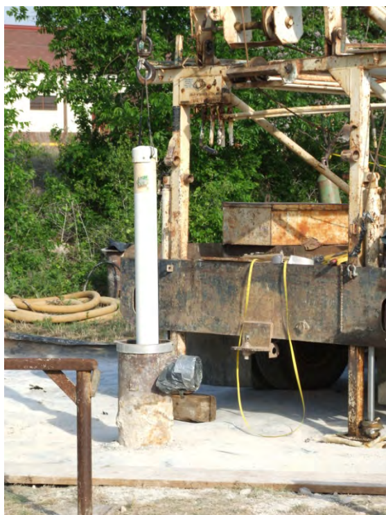
Photo 2.1 – Installation of CS-MW35-LGR.
